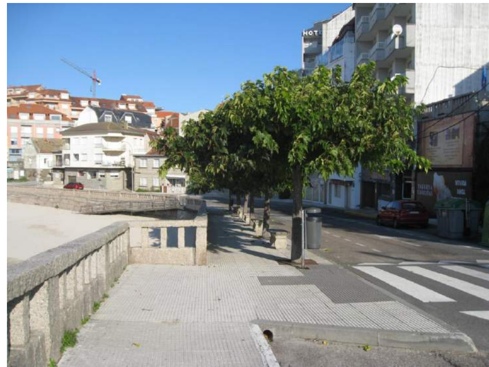
Acera de la Playa de Caneliñas, a reponer con nuevo pavimento (Tramo 3)
