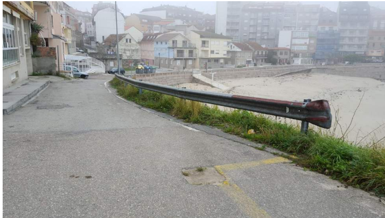
Bionda a sustituir por otra de madera, acorde con el entorno (tramo 4)
