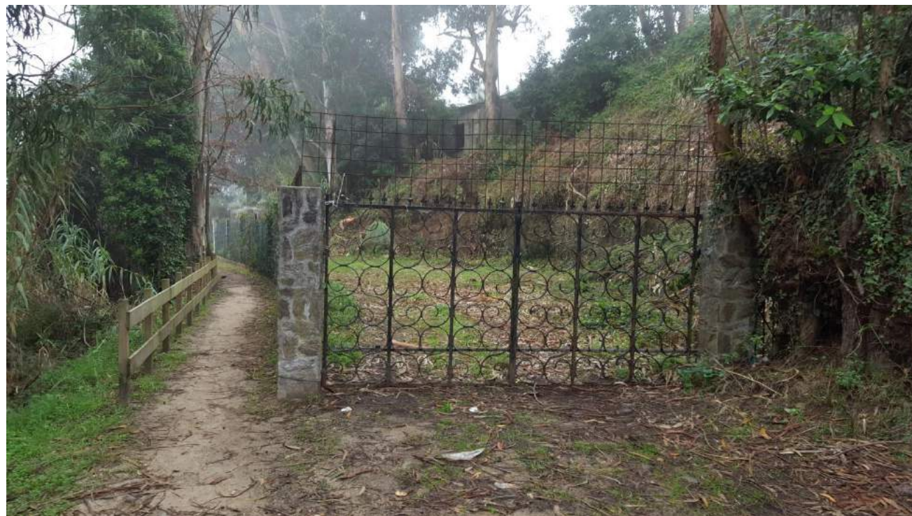
Puerta metálica a retirar, por donde discurre la senda de jabre de 2 m (Tramo 5)
