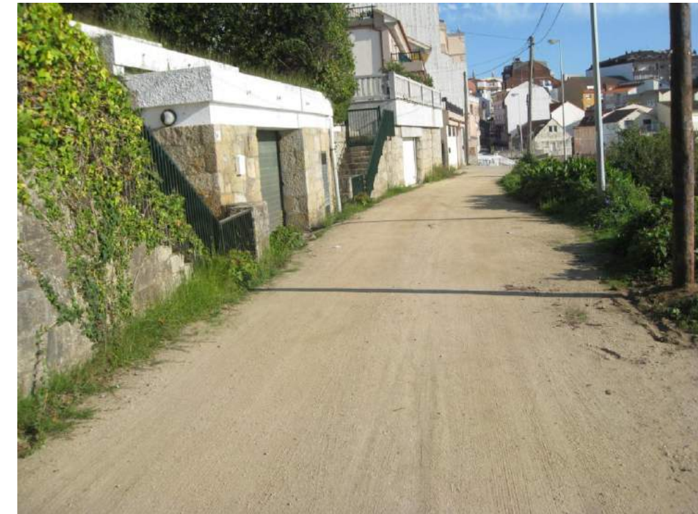
Prolongación de la Avda de Pontevedra, donde se ejecutará un pavimento mixto (Tramo 4)
