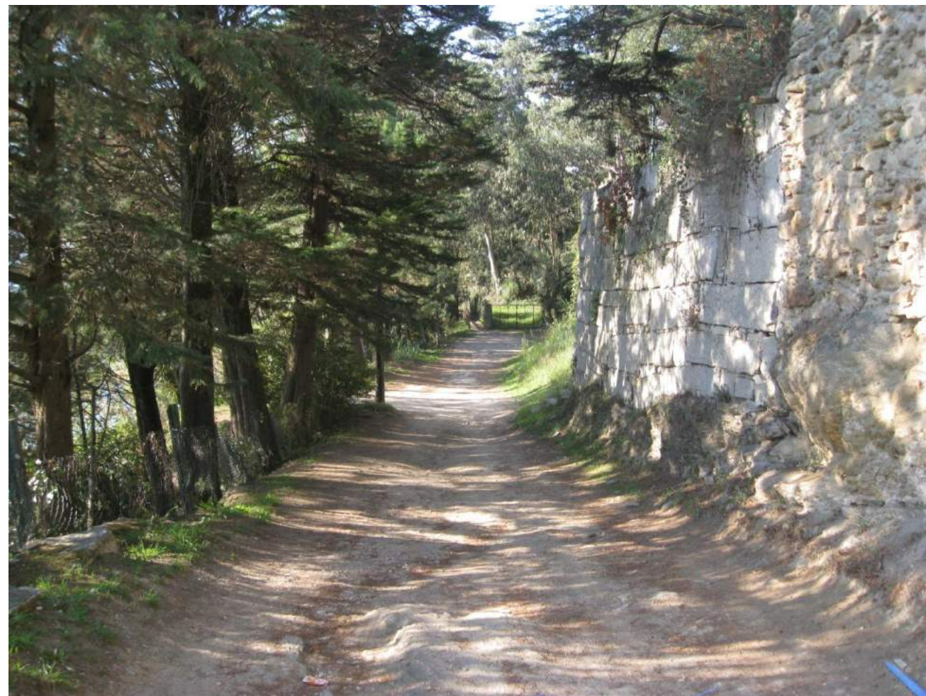
Prolongación de la Avda de Pontevedra, por donde se ejecutará la senda de jabre de 2 m de ancho (Tramo 5)
